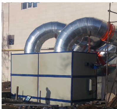
نصب مدل IncoTA/S-850 با کوره دوقلو که نیمه آن زیر سطح زمین قرار گرفته است
